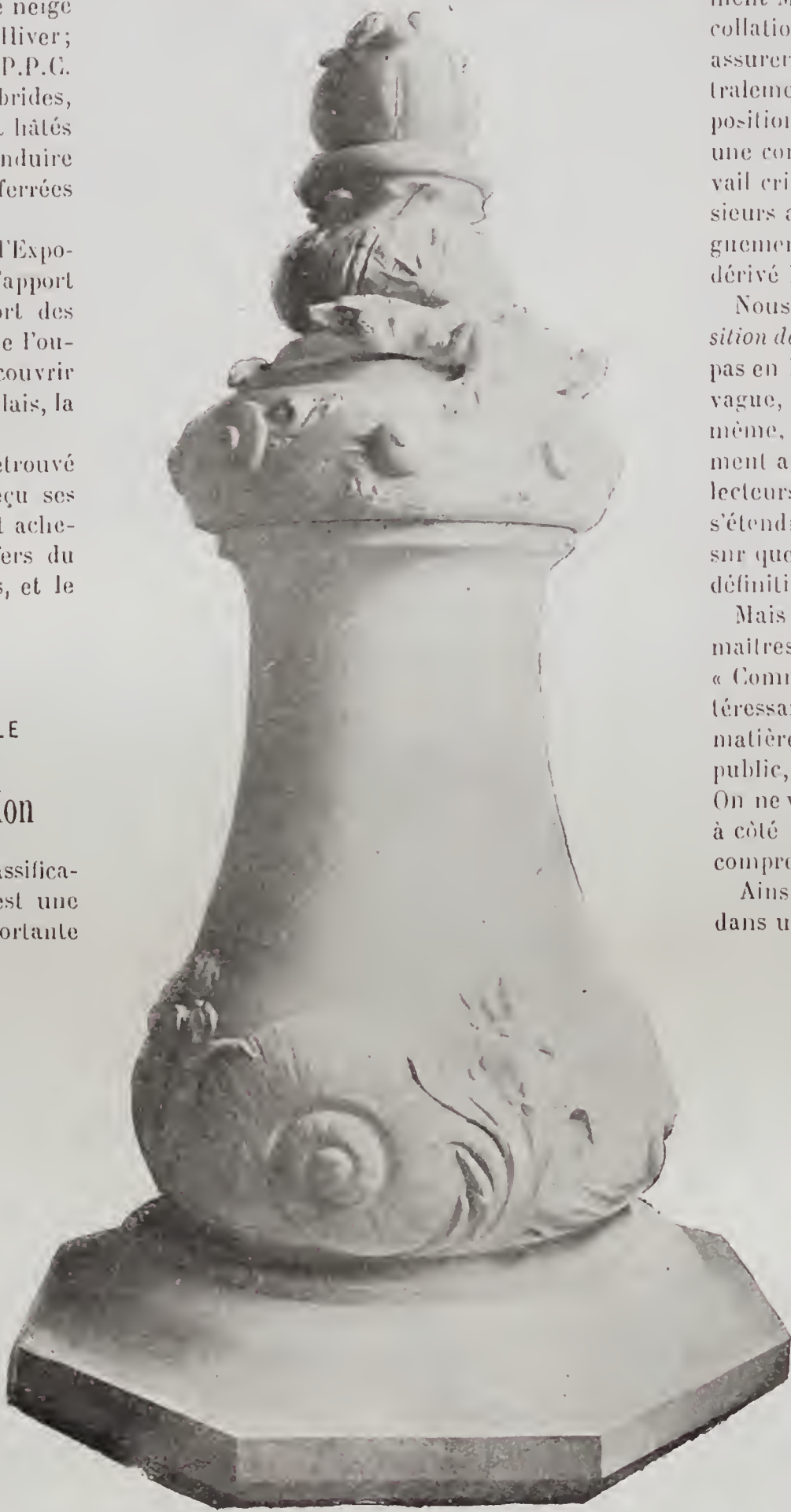
L'ORNEMENTATION DU PONT ALEXANDRE. — Pilot d'amarrage, en fonte de fer, sur le bas-quai.
